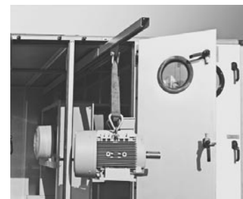
Auszugsvorrichtung zur Motorrevision
