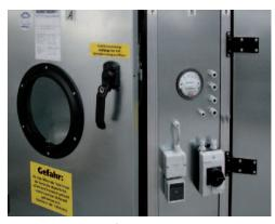
Gerätetür mit Sichtfenster und Hebelverschluss
