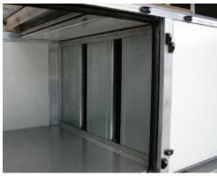
Kulissenschalldämpfer mit Membranabdeckung
