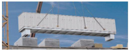
RLT-Gerät System TwinBox zur Verringerung der Schallemission für das Werk von Wagner-Pizza, 30.000 m³/h Luftleistung
