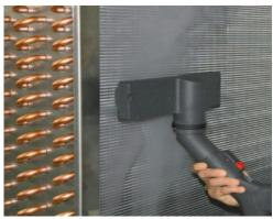
Reinigung mit Dampf und Druckluft und Absaugung, alternierend von beiden Seiten
