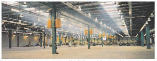
Lüftungsgeräte mit insgesamt 360.000 m³/h Luftleistung belüften die Produktionshallen beim Getriebehersteller ZF in Saarbrücken. Die Aufnahme zeigt einen Strömungsversuch.
