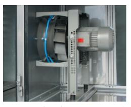
Ventilator mit freilaufendem Rad System ETA®
