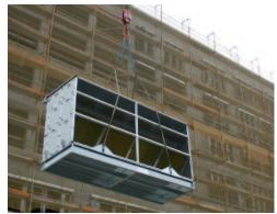
Demontierbare Kranösen, stabile Geräterahmen
