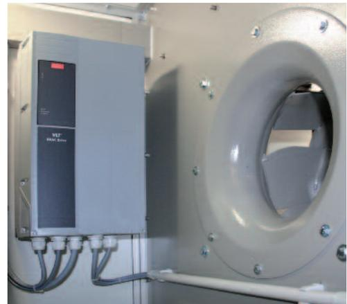
Geringe Energieverluste durch kurze Zuleitungen
