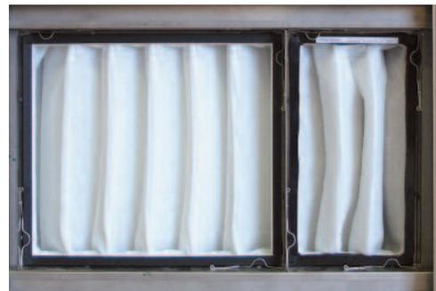
Taschenfilter mit Filterrahmen-Schnellspannklammern für eine problemlose Revision
