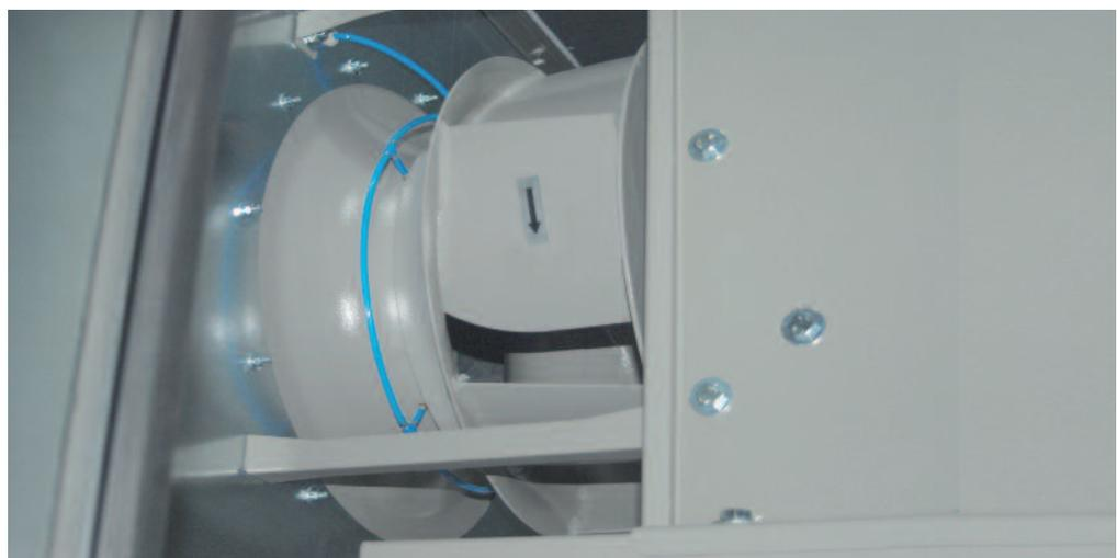
Freilaufendes Rad mit Volumenstrom-Messsystem
