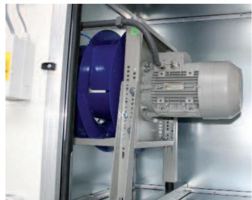
Freilaufendes Rad - Ventilator System ETA®
