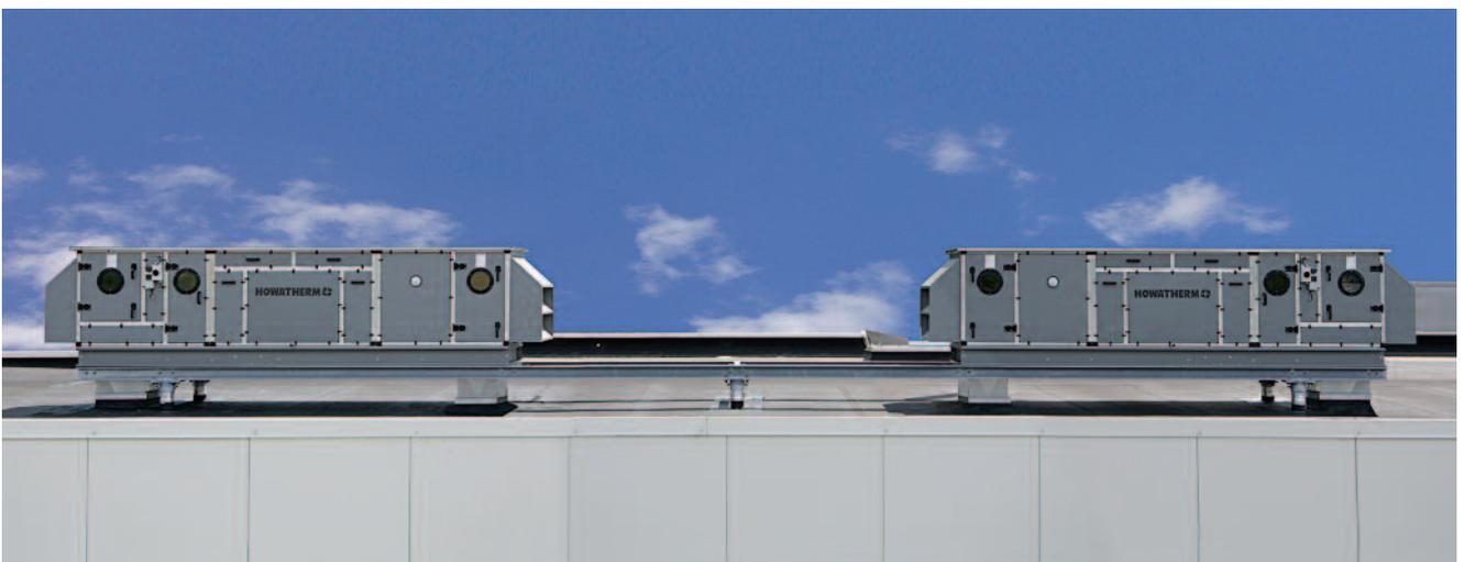
Neues energieeffizientes Verfahren System TwinXchange: intermittierendes RLT-Gerät zur Raumlüftung mit Umschaltregenerator
