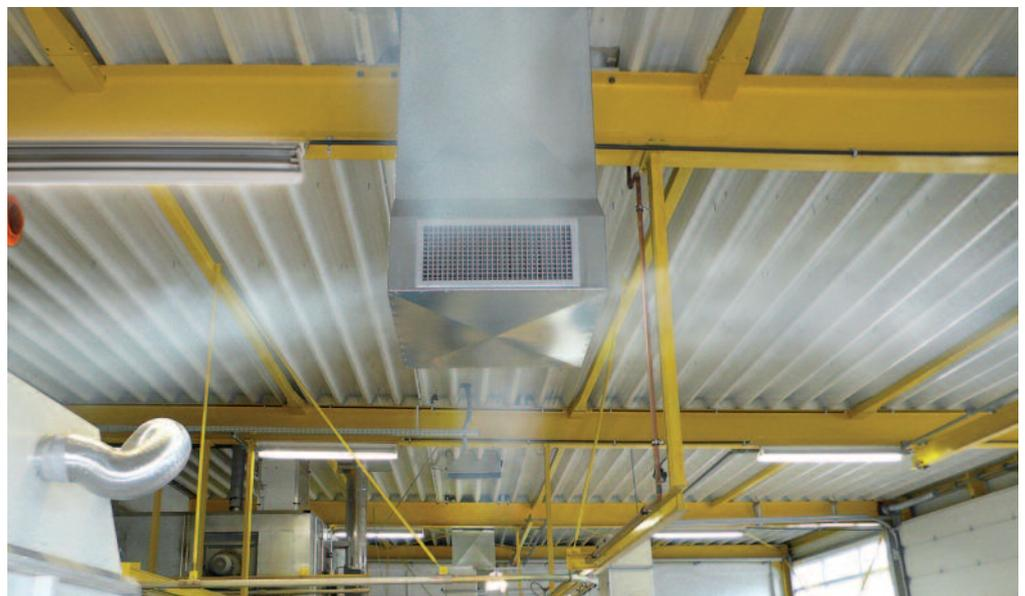
Strömungsversuch: Ausblaskopf Zuluft vorne und Ansaugschacht Abluft hinten
