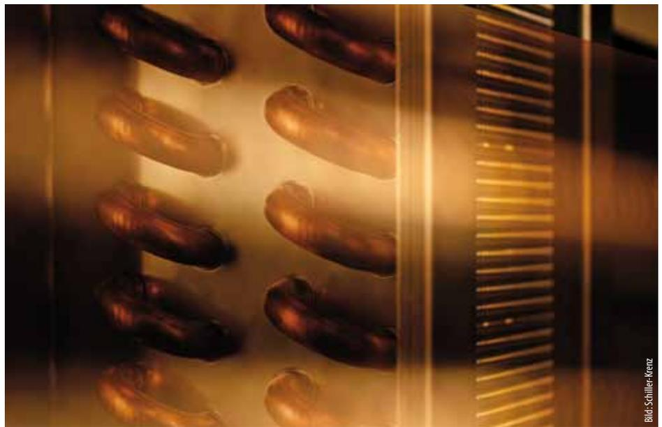
1 Berippter Wasser/Luft-Wärmeübertrager zur hocheffizienten Wärmerückgewinnung in einem RLT-Gerät.
