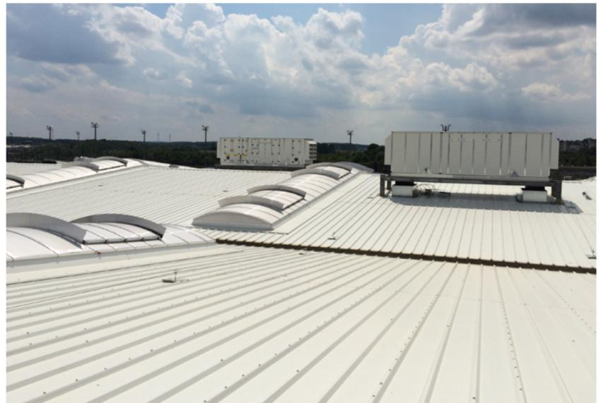
Anordnung von insgesamt 18 RLT-Geräten System **TwinXchange** by HOWATHERM® auf dem Hallendach
