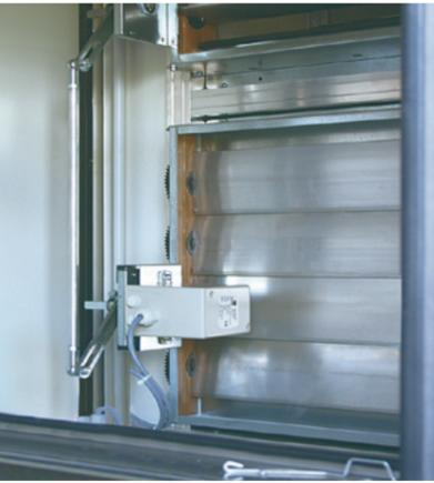
Luftregel- und Absperrklappen mit strömungstechnisch optimierten, drehbar gelagerten Lamellen aus Aluminium-Hohlprofilen, mit Verstellung über Vierkantwelle und umlaufender Rahmeneinfassung mit folgenden Merkmalen:
