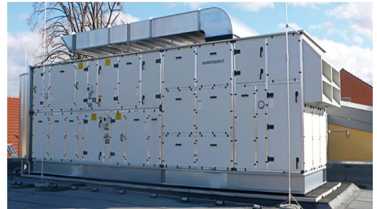
Raumlüftungsgerät System CrossXchange by HOWATHERM® für die Fachhochschule Soest mit 10.000 m<sup>3</sup>/h Luftleistung
