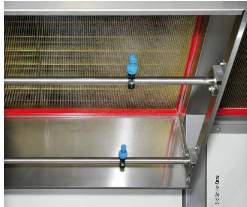
14 Plattenwärmeübertrager-Hybridbefeuchtung mit dem System Hydroplus by Howatherm.
