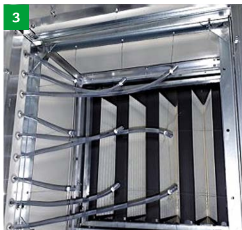
Verteilung der neun Partikelmessstellen über den Querschnitt
