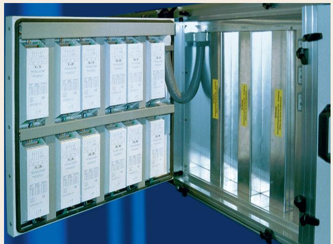
**Bild 8:** Schaltschrankeinheit im RLT-Gerät. Bild: Schiller-Krenz
