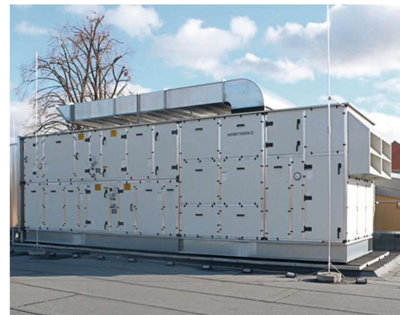
Raumlüftungsgerät SystemCrossXchange by HOWATHERM® für die Fachhochschule Soest mit 10.000 m³/h Volumenstrom
