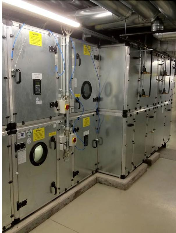
Hydraulikmodul WRG mit integrierter Wärmepumpe
